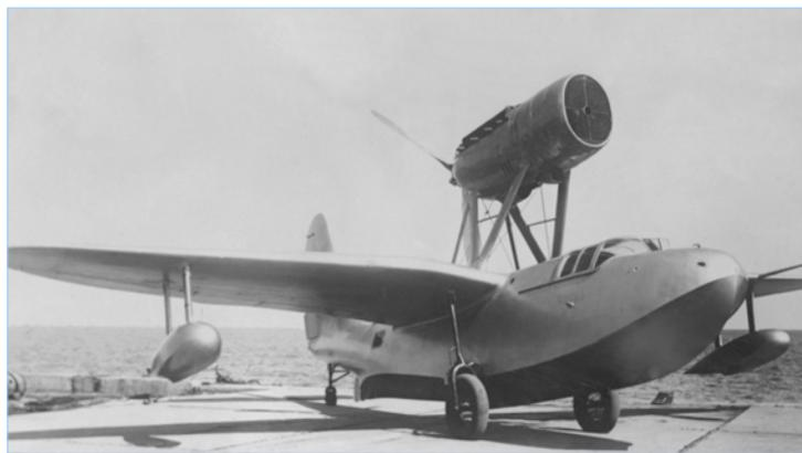
В 1938 г. была предпринята попытка создать гидросамолет для замены МБР-2. Новый МБР-7 (ЦКБ МС-8) имел лучшую аэродинамику и более мощный двигатель. Летные испытания гидросамолета начались в апреле 1939 г. Однако из-за очень сильного крутящего момента, создаваемого винтом и высоких взлетной и посадочной скоростей, МБР-7 испытаний не выдержал и серийно не строился.
